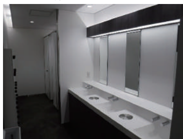
給排水・衛生工事
