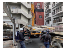
建築物解体／駐車場解体／ その他解体作業
