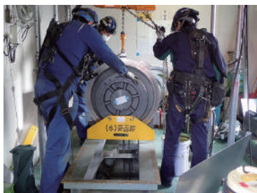
エレベーター更新工事
