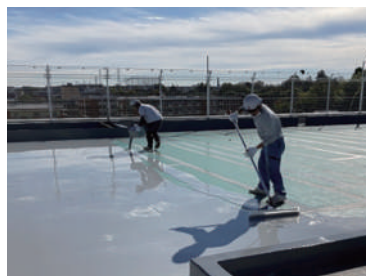
屋上防水工事
