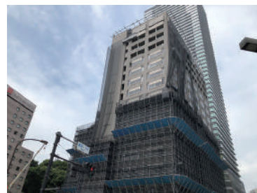
大規模修繕工事
