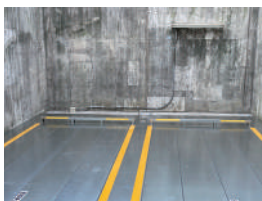
機械式駐車場平面化／ 足場組立／コンクリート敷設
